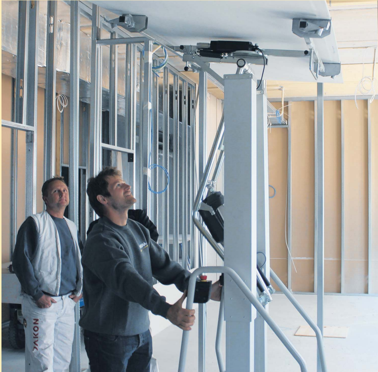
Sådan monterer du gipsplade i loft – ren fjernbetjening
