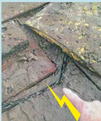
Ubeskyttede/ødelagte kabler på jernpladeveje og andre køreveje
