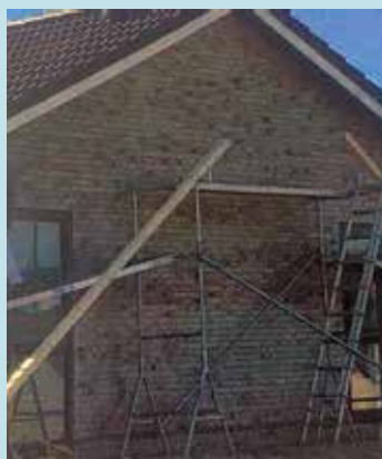
Bukkestilladser, der er samlet efter forhåndenværende-søms-princip
