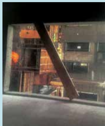
Manglende opsætning af rækværk efter demontering
