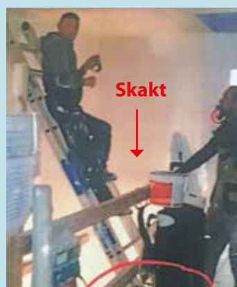
Manglende opsætning af rækværk efter demontering
