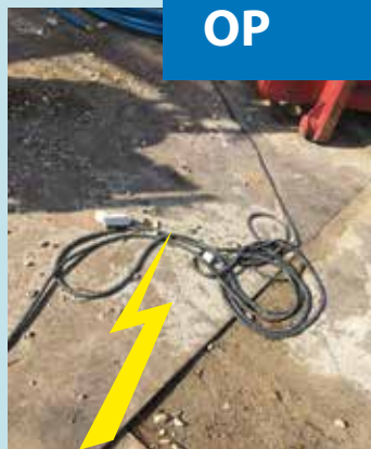
Ubeskyttede/ødelagte kabler på jernpladeveje og andre køreveje
