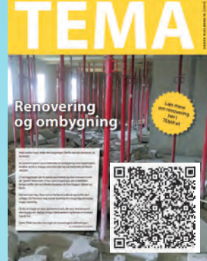
Renovering og ombygning
