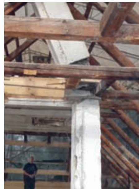
Skorstenspipe, der endte nede i kælderen
