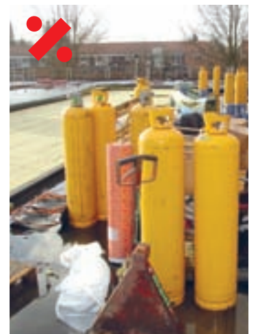
Forkert opstillede gasflasker
