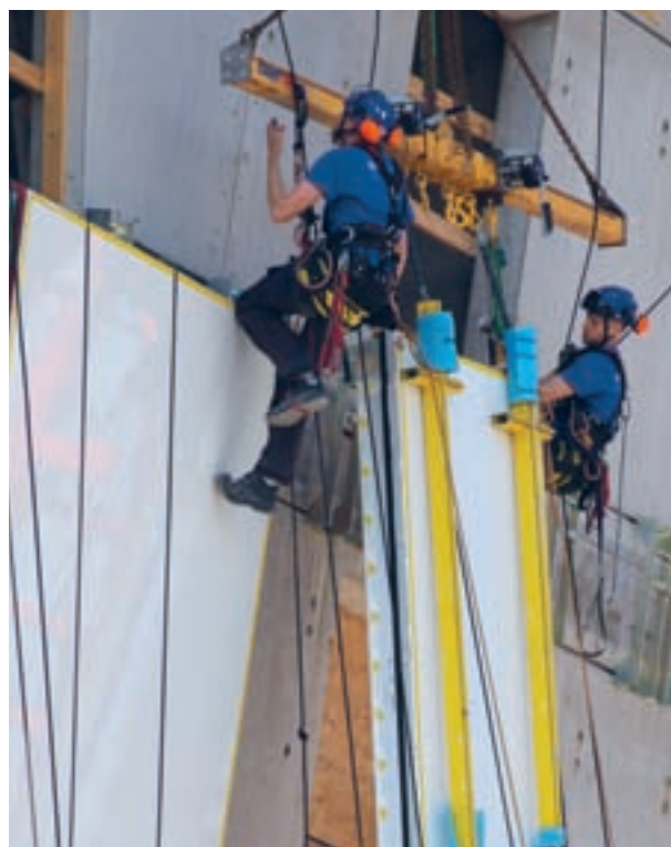
Montage af facadeelement på den udadgående gavl i ca. 50 meters højde.
