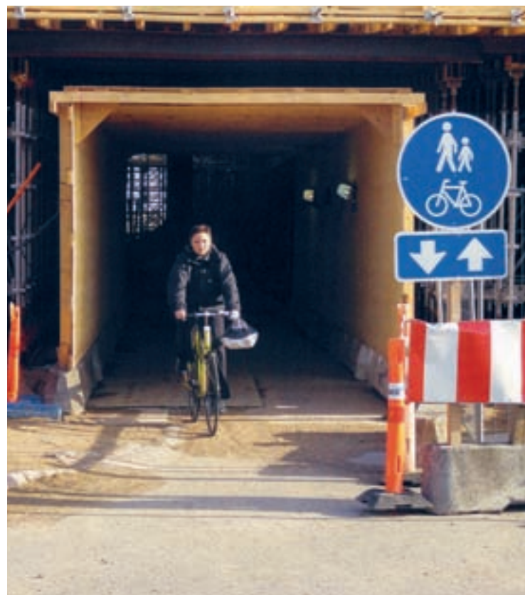
I forbindelse med udvidelsen af Holbæk motorvejen ved Fløng, har man lukket Hedevej for kørende trafik. Vejen skal dog stadigvæk kunne benyttes af gående og cyklister. Det har resulteret i, at der er blevet bygget denne flotte overdækkede tunnel, som beskytter gående og cyklister mod arbejdspladsen og mulige faldende genstande.
