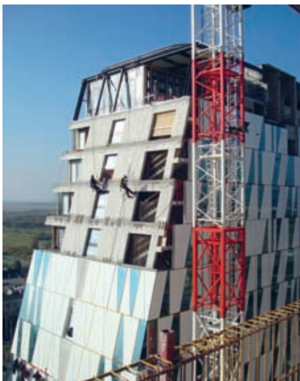
Der bliver gjort klar til facademontage i ca. 70 meters højde
