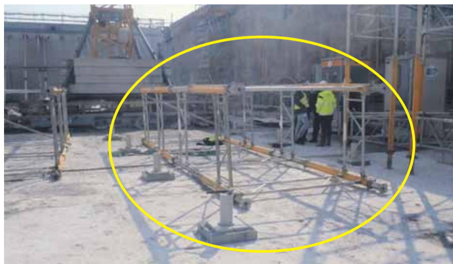
Her ses det væltede Multiprop tårn (inde i cirklen) i bunden af Dokken. Tårnene samles liggende på dokgulvet og rejses efterfølgende. Se et ikke rejst tårn til venstre for ulykkestårnet.
