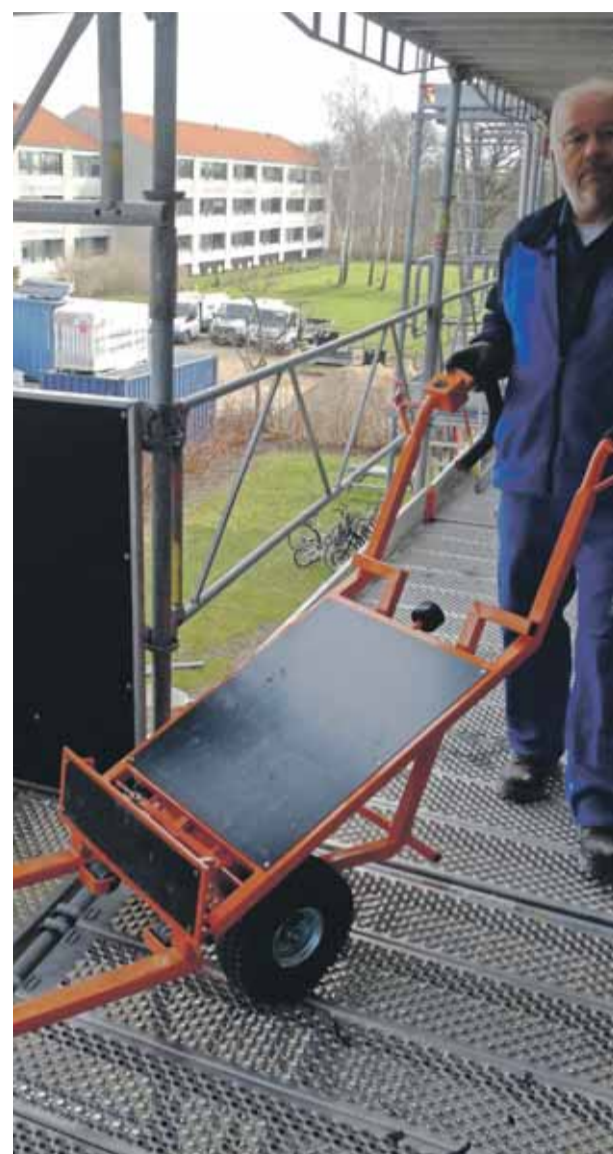
Så er det bare med at følge med, når vognen nærmest selv kører ned i den anden ende af stilladset.
